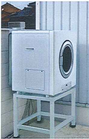
雨のかからないベランダに専用台(低)設置
